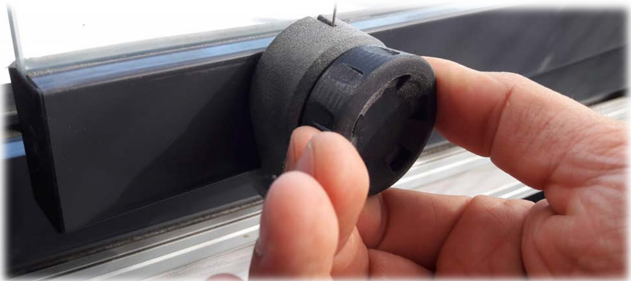
Kuva 3. Nupista pyöräyttämällä ylä- ja alalukkotelki avautuu ja lasielementti on käännettävissä.
